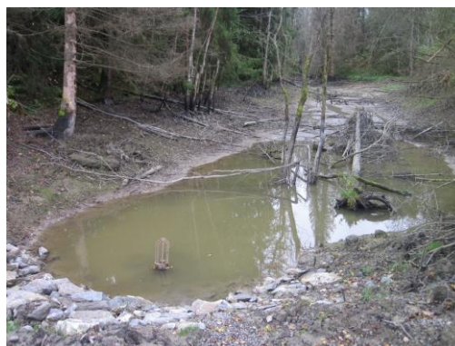
Figur 1 Fordrøyningsdam før innløpet til lukkingsanlegg
